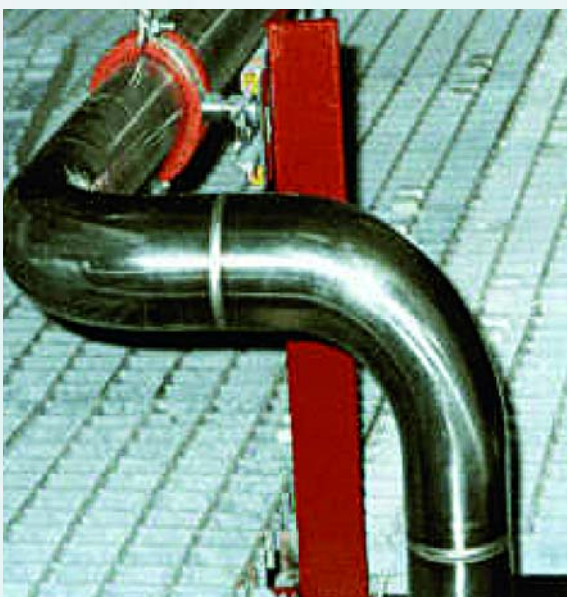
◀ Particolare saldatura automatica Orbital welding
